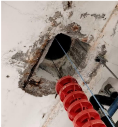
Figur 3, spjälkad och blottad armering vid genomföring för lindrag. Källa: Skadeutredning tävlingsbassängen (25m) WSP 2024-09-06
