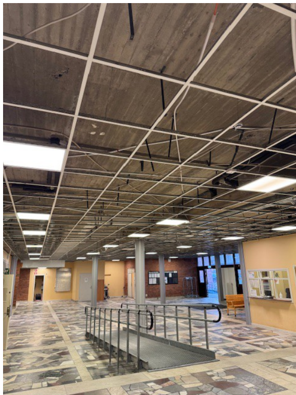
Undertaksplattor nedtagna för säkerställande av projektering rördragning.
