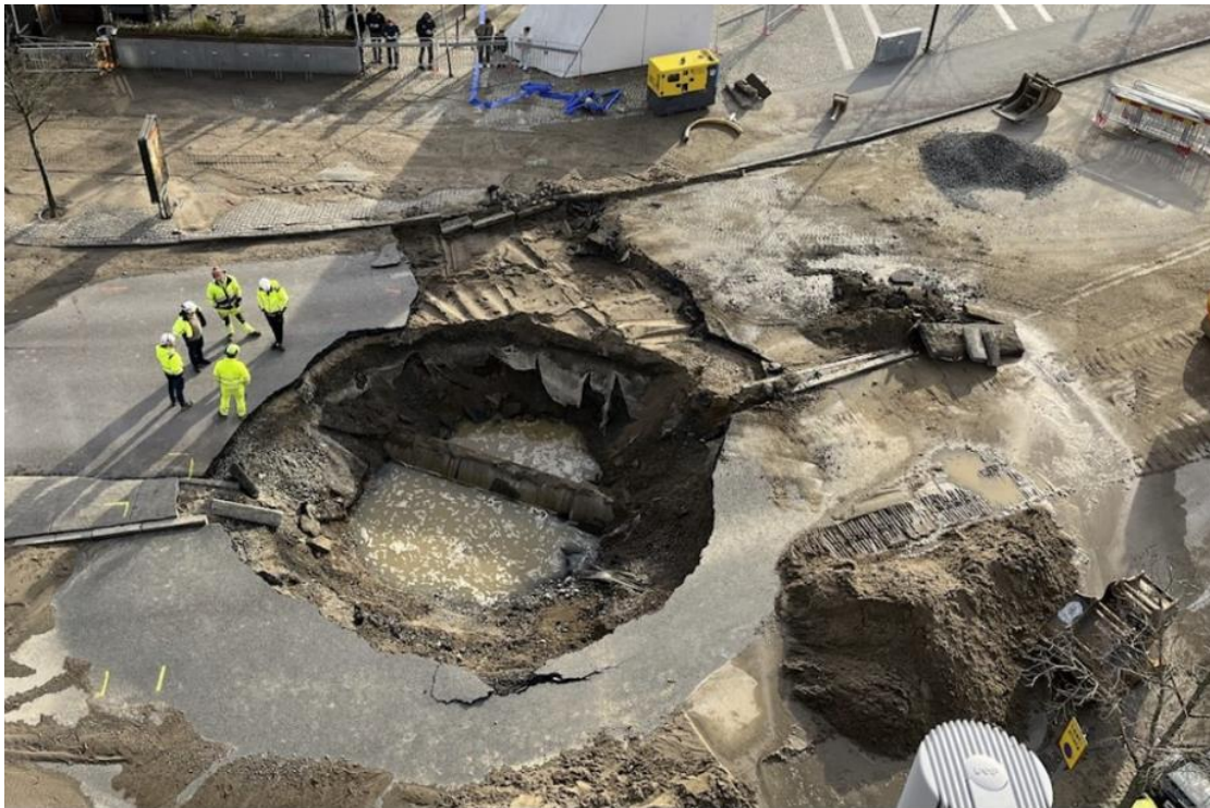
Figur 3: Lokal konsekvens av en brusten huvudvattenledning, Jönköping 2025
