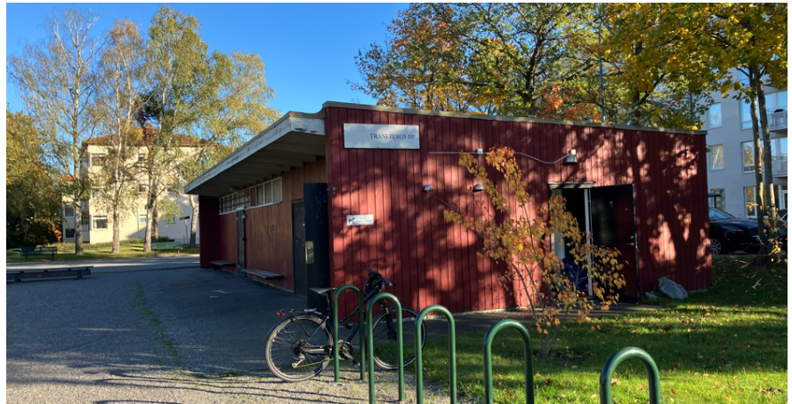
Bilden visar befintlig servicebyggnaden inom planområdet, placerad i anslutning till parkens gångstråk.
