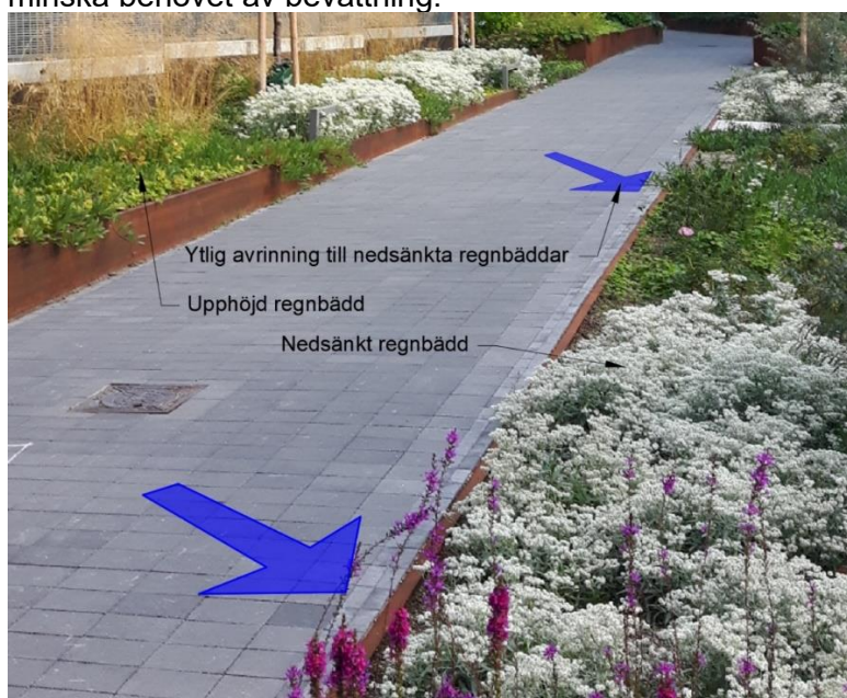
Figur 14 Illustration över en kombination av upphöjda respektive nedsänkta regnbäddar med ytlig avrinning från hårdgjord mark till nedsänkta grönytor
