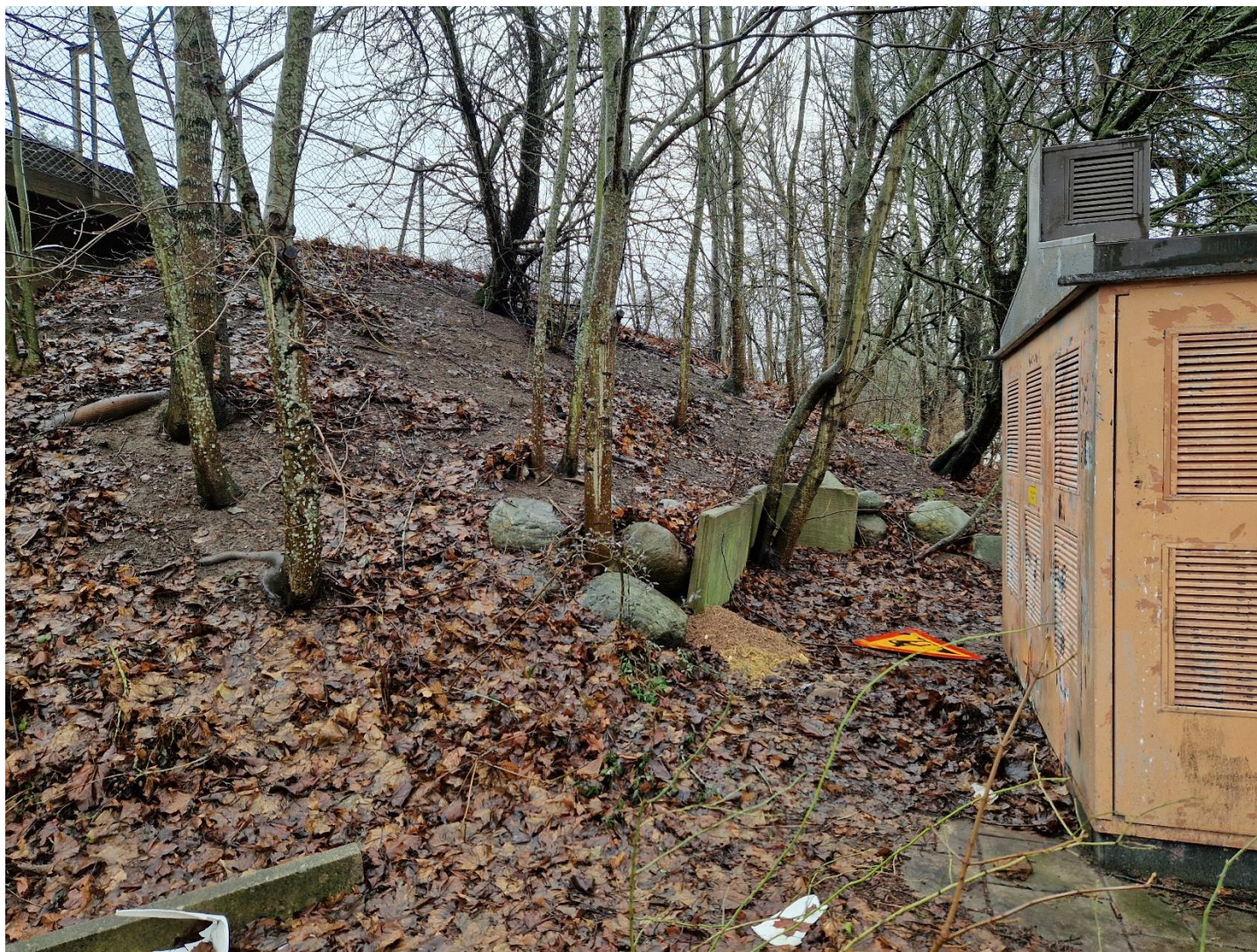
Figur D-4 Vy söderut, banvall, stödmur och nätstation.
