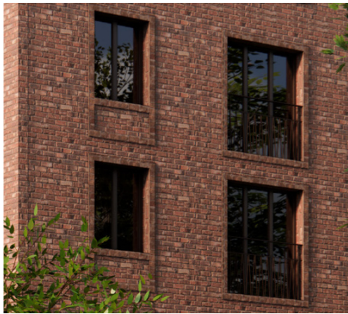
Illustration som visar fönsterramar i livförskjutet tegel. Illustration: KEJS arkitekter
