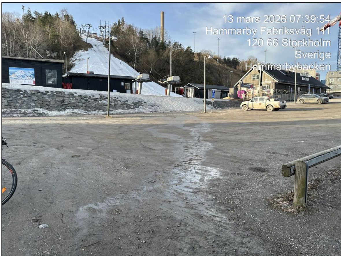
Smältvattnets väg sedd från norr. Flödesvägen stämmer med prognosen för 100-årsregnets flödesväg.
