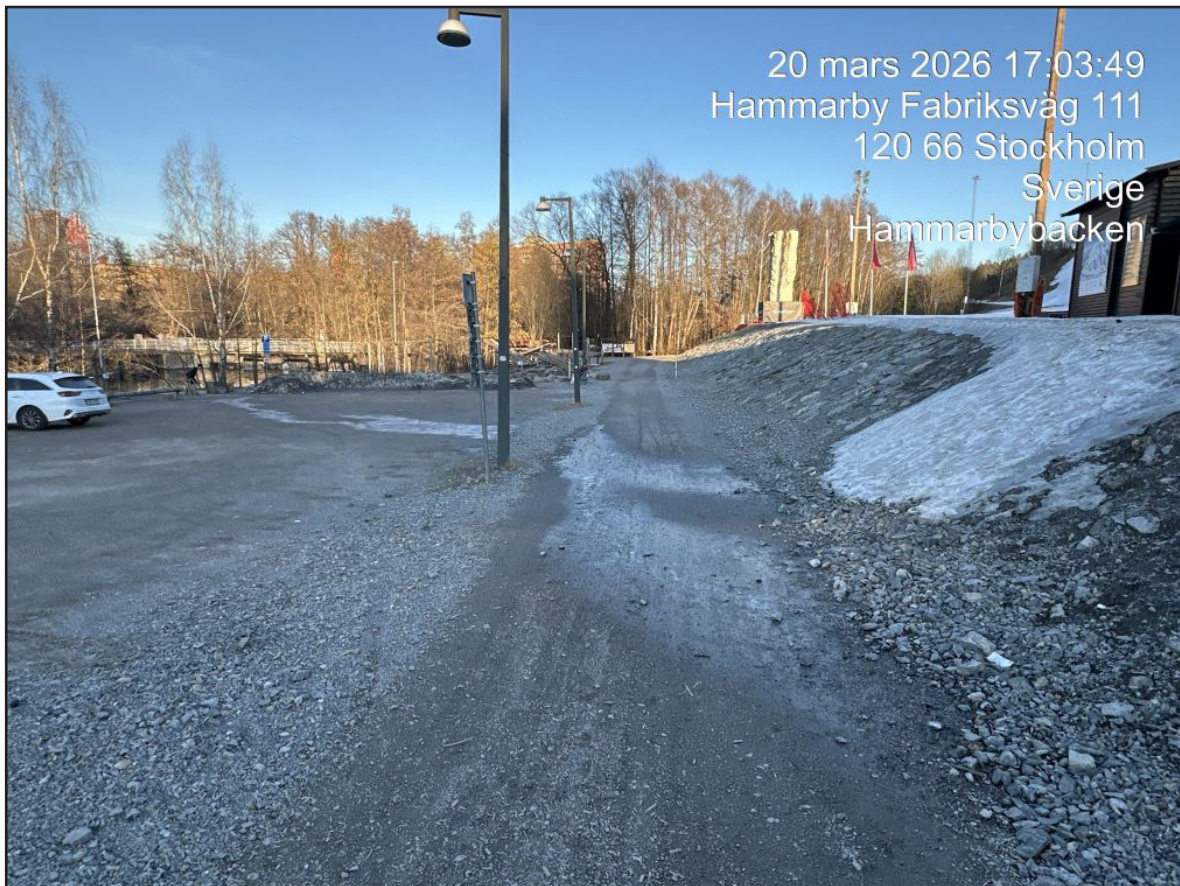
Dagens flödesväg för smältvatten stämmer med prognosen för 100-årsregnets flödesväg, se bild på föregående sida. Vid minusgrader blir vattnet is, risk för halka.
