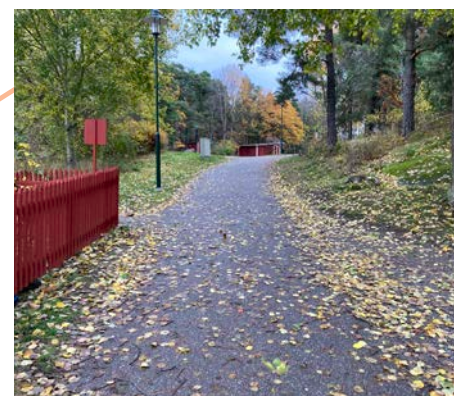
Slingan upp mot Årstaliden består av asfalt med stora inslag av rötter.
