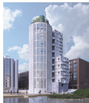
Den södra silosens rör utformas med vertikala fönsterslitsar som löper över flera våningar. Den norra silosens rektangulära del ges kontrasterande gestaltning för att hantera buller och mikroklimat.
