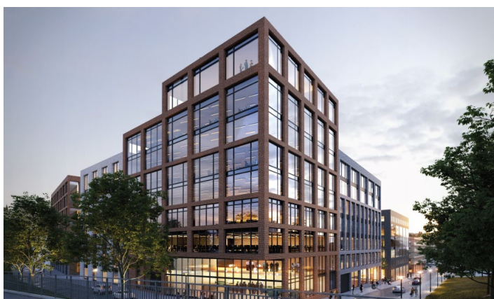
En nio vånings byggnad markerar entréläget vid Huvudstabron.
