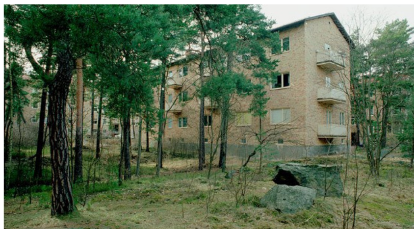
Mellan smalhusen i Abrahamsberg framträder grönska i form av främst tall och hällmark är sparad mellan husen.
