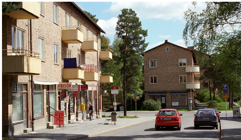
Centrumbildning vid Rörläggargvägen, Abrahamsberg. Gaveln fungerar här som ett fondmotiv på gatan.
