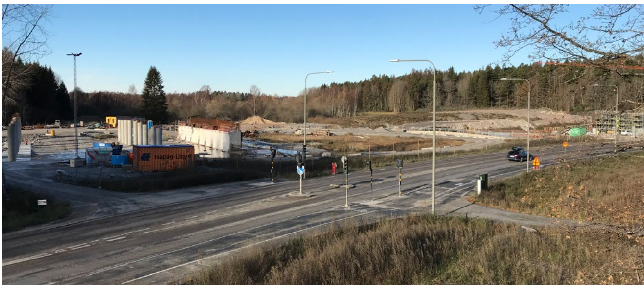
Figur 27. Vy not norr över Hästa klack och Akallaälänken med pågående arbete av Förbifart Stockholm.
