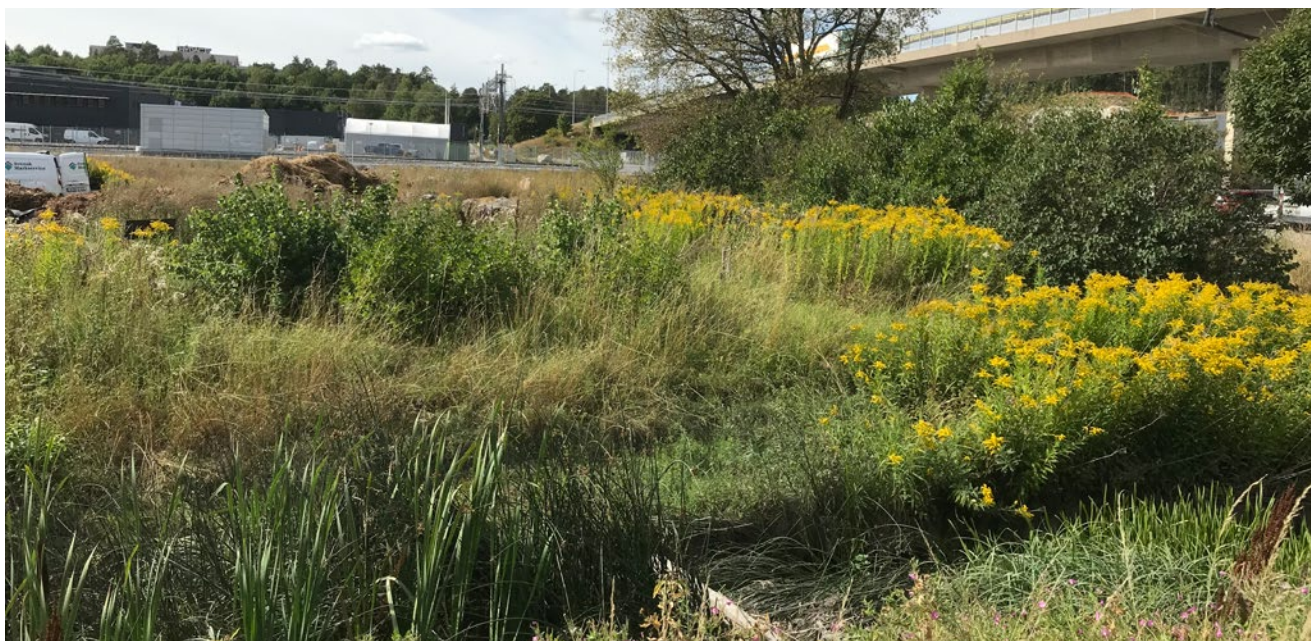
Figur 44. Planerad passage av markkabeln vid Bällstaån. I förgrunden syns Mäljarbanan och Bergslagsvägens vägbro. Passagen planeras med styrd borring.
