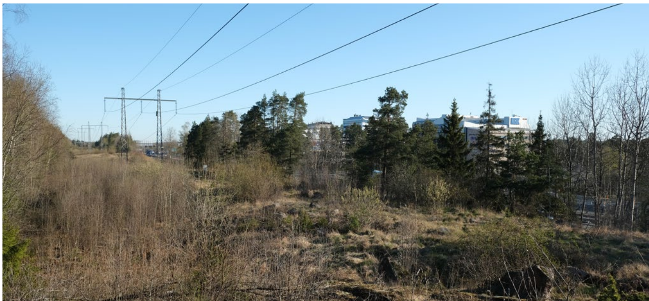
Figur 30. Befintlig ledningsgata för Svenska kraftnäts 220 kV-ledning längs E4:an vid Häggvik.
