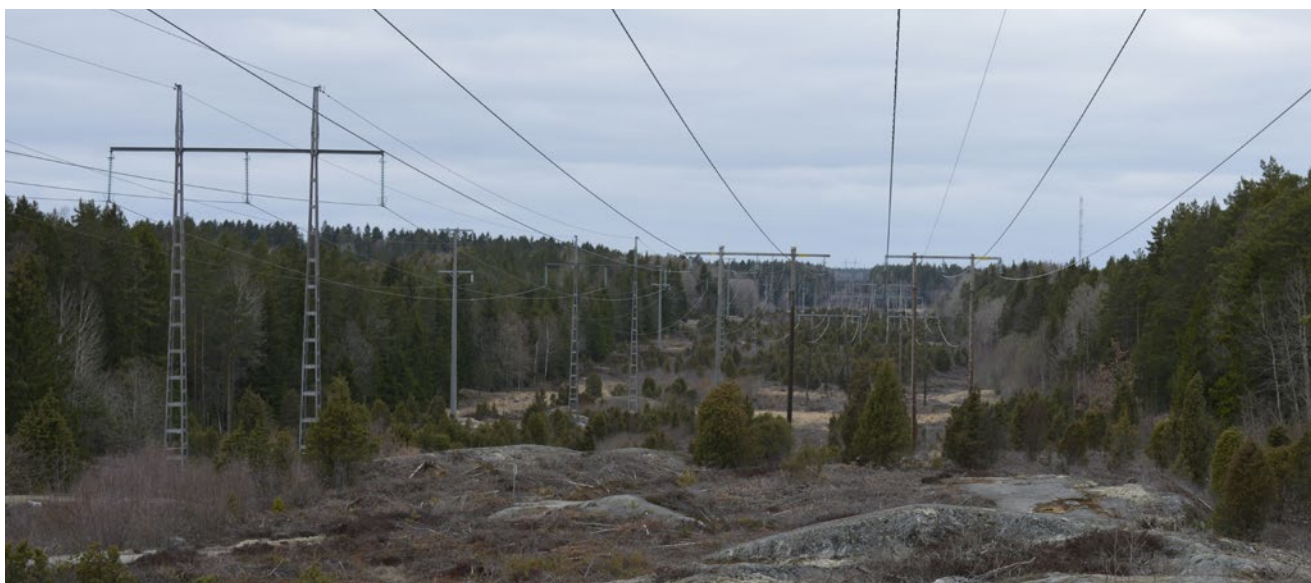
Figur 21. Befintlig ledningsgata i ett slutet landskap vid Viby. Från vänster till höger visar fotot Trafikverkets enkelstolpe, Svenska kraftnäts portalstolpe och Vattenfalls två portalstolpar. Vy mot norr i riktning mot station Överby.
