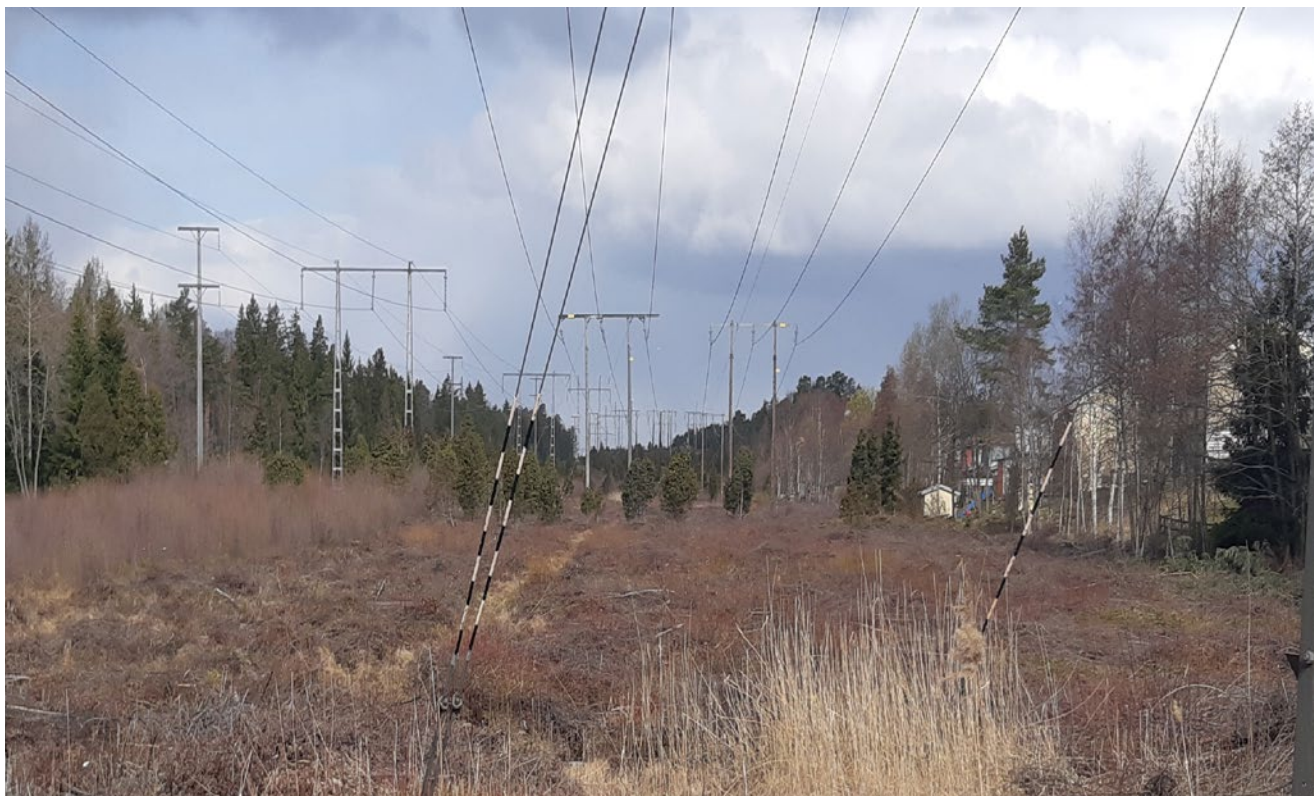
Figur 28. Boendemiljö och befintliga ledningar vid Viby.
