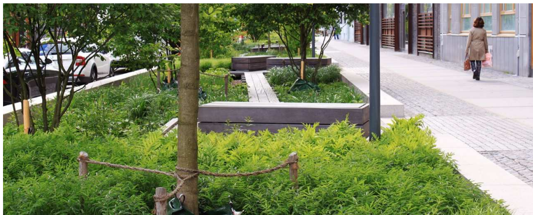
Exempel på förstärkt dagvattenhantering i ett exploateringsprojekt: Regnbäddar på Jaktgatan i Norra Djurgårdsstaden. Foto: Lemmart Johansson
