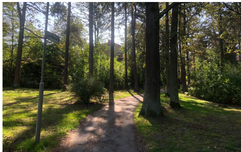
Asfalterad gångväg med belysning.
