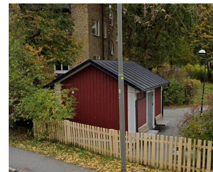
Teknikhus Gustav III:s väg
