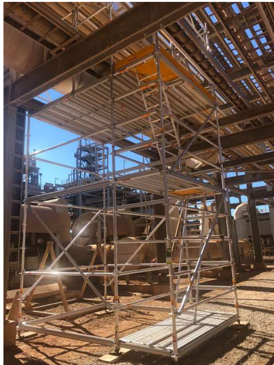
BYGGSTÄLLNINGAR - bl.a. Monzon "No Limit"
