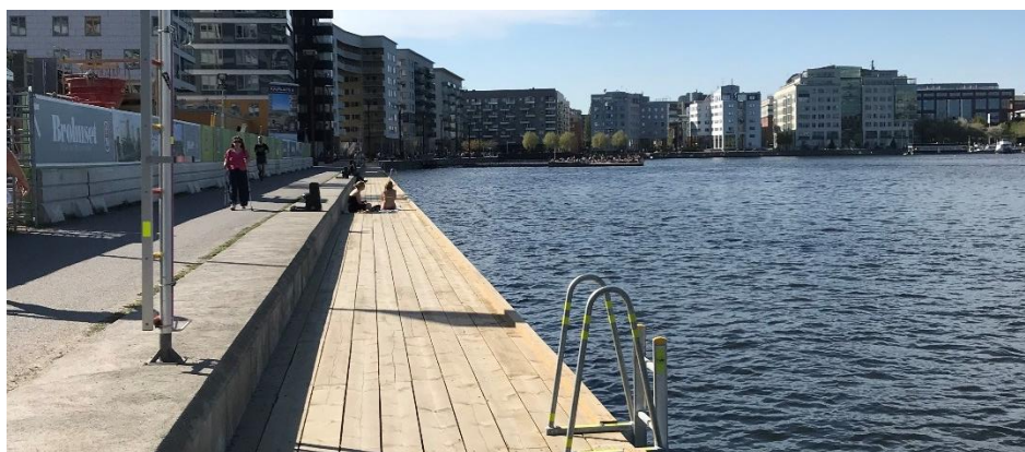
Kajen vid Årstadal. Vattenmiljön påverkas här både av tidigare muddringar och utfyllnader och av att kajerna skuggar botten i strandkanten. Foto: Iréne Lundberg.
