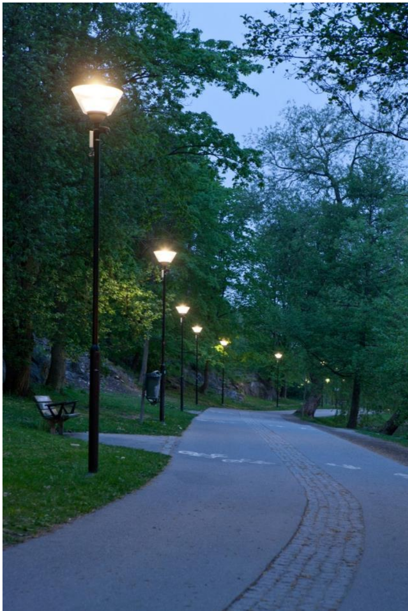
Foto: Med hjälp av smarta belysningsåtgärder går det att ställa in hur starkt utomhusbelysningen ska lysa under dygnets mörka timmar och automatiskt justera styrkan utifrån närvaro eller tid på dagen. Exempel från Kungsholmens strandstig.
