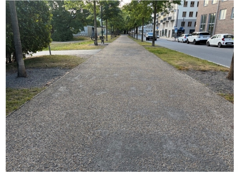
Enkel ytbehandling på grusunderlag Ett lager pågrus, utlagt och vältat på en spridning emulsion.
