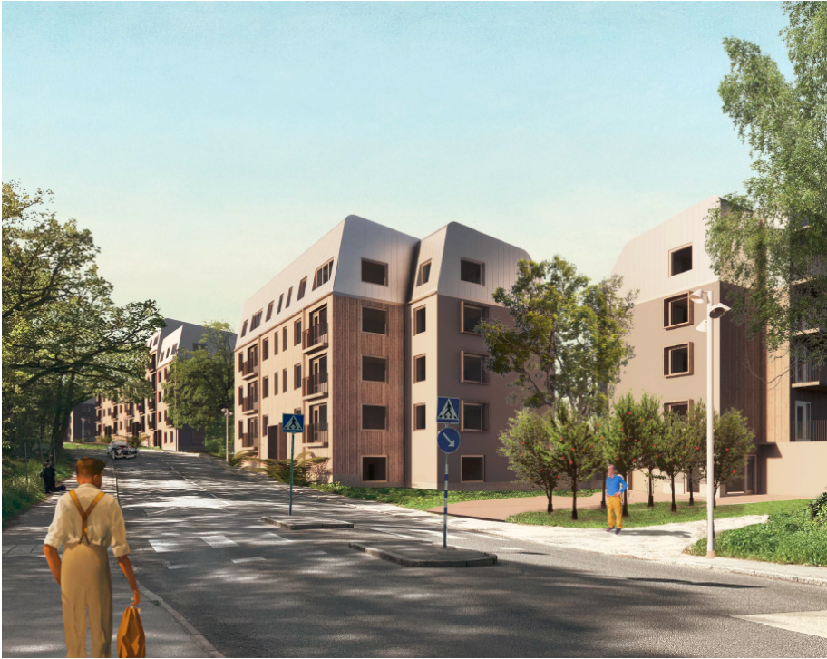
Vy från Gubbkärrsvägen sett från norr
