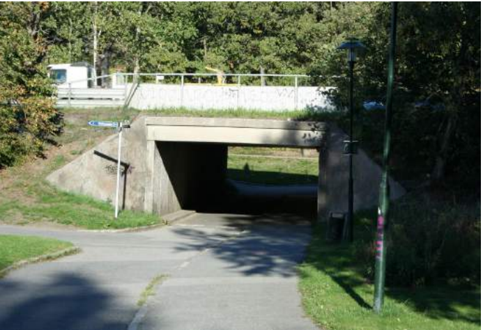
Gångtunnel under Nynäsvägen
