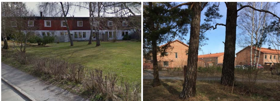
T.v. Norra Sköndal sett från Gråhundsvägen. T.h. Radhusområde inom fastigheten Helikoptern. Foton tagna 2019.
