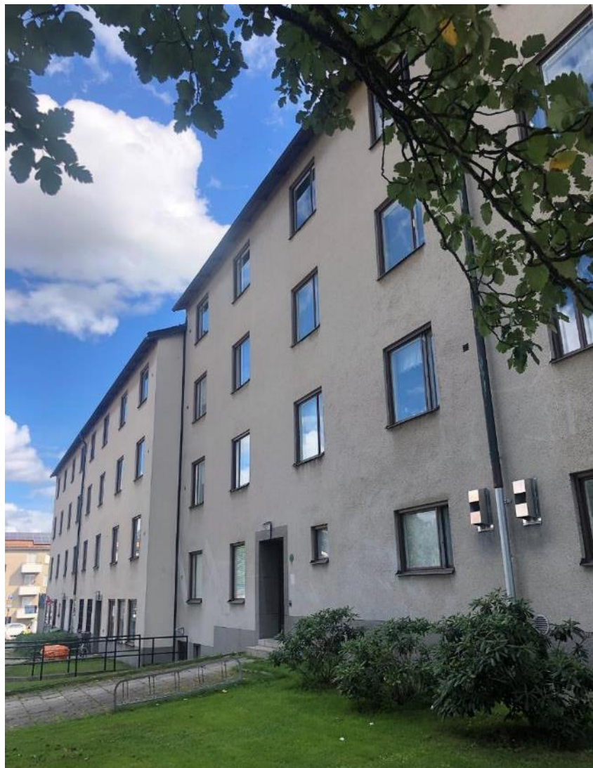
Vy mot kvarterets förgårdsmark mot Lysviksgatan i norr. (Bild: Vardag)
