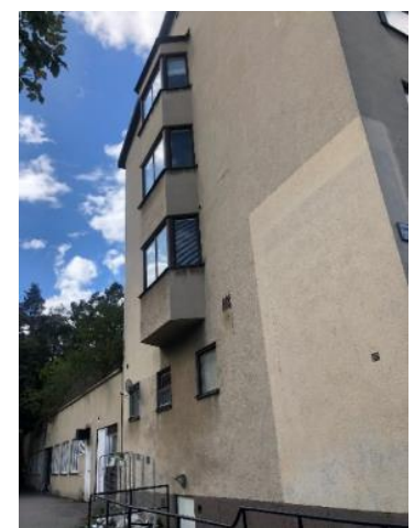
Bilder från bebyggelsen – till vänster mot gården, till höger mot infarten till garaget från öster. Byggnaderna är utförda med fasader i ljus beige ädelputs med fönsterkarmar och portar i brunmålat trä. Utanpåliggande balkonger med räcken av vit sinuskorrigerad plåt. Sadeltak av rött tegel. (Bild: Vardag)
