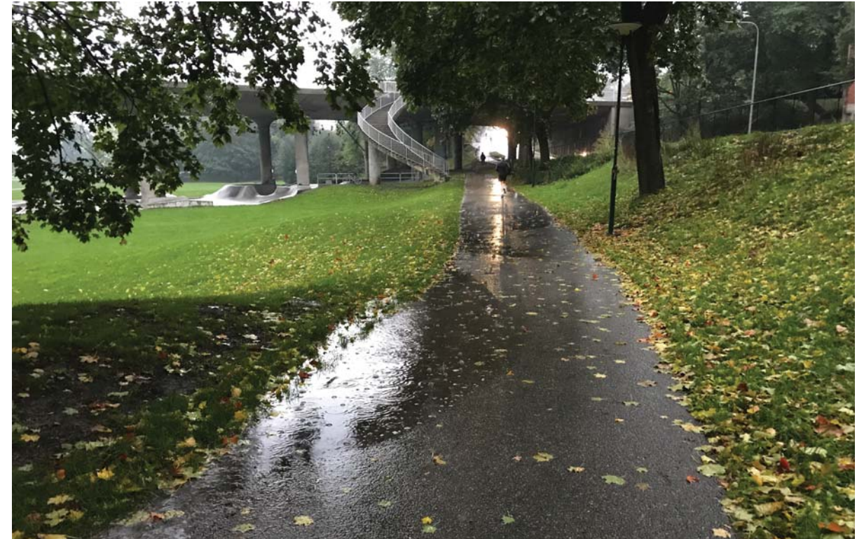
Pölbildningar på gångvägar vid regn.
