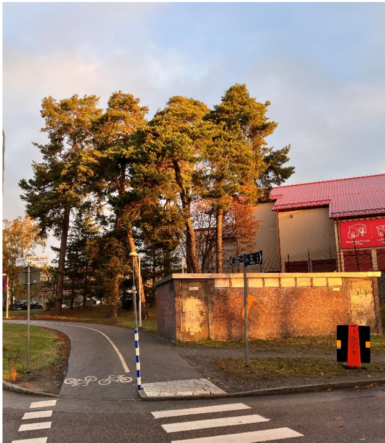
Tallar bakom elnätsstationen på Vinthundsvägen.
