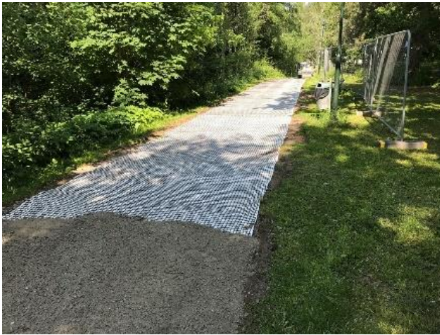
Figur 9. Bilder från Ölmevägen och anläggning av Geonät. (Ekman 2021).
