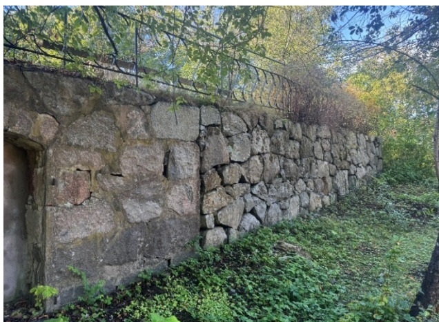
Källargrunden och terrassmuren sett från nordöst.
