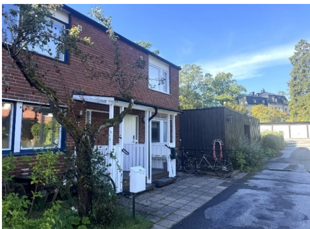
Radhus söder om planområdet med entréer och utstickande lågdela. Sett från nordöst.
