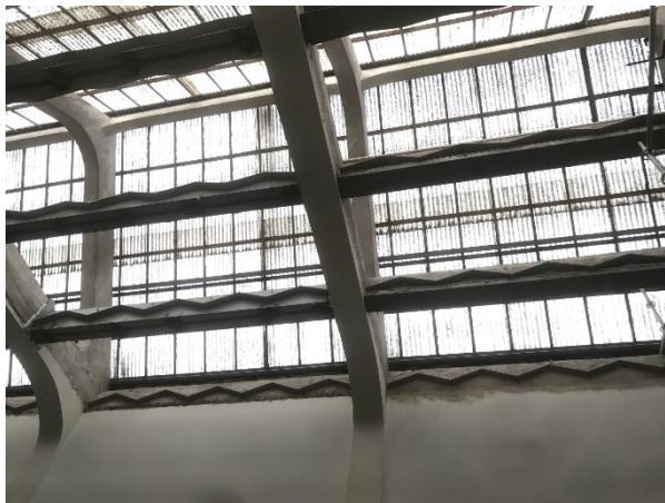
Figur 3, Före ombyggnad, lanterniner i korrugerad plast.
