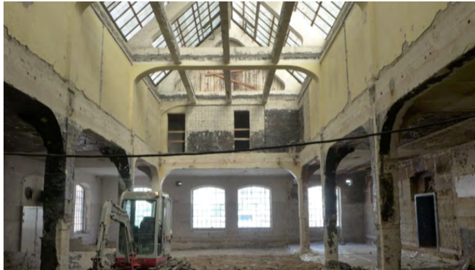
Figur 2, Utseende efter rivning av bjälklag och betongglas.
