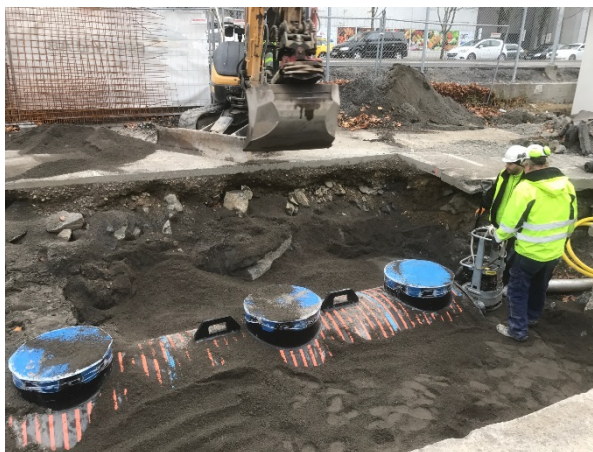
Figur 8 a, b, c, spräckning av berg samt installation av fettavskiljare.
