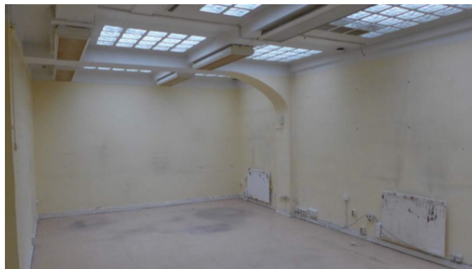
Figur 1, Utseende innan rivning av mellanbjälklag och betongglas.
