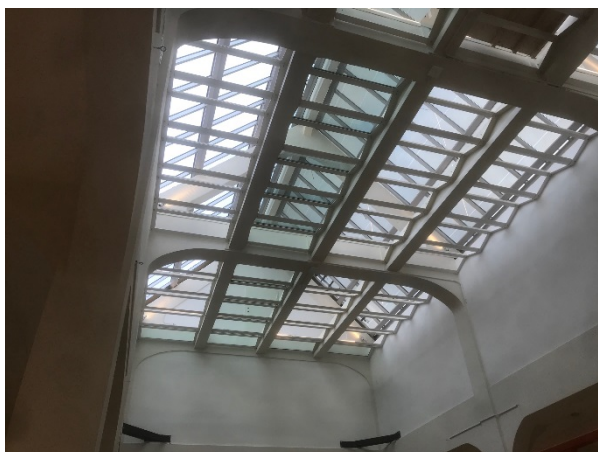
Figur 4, Efter ombyggnad, lanterniner i glas med inlaminerade solceller.
