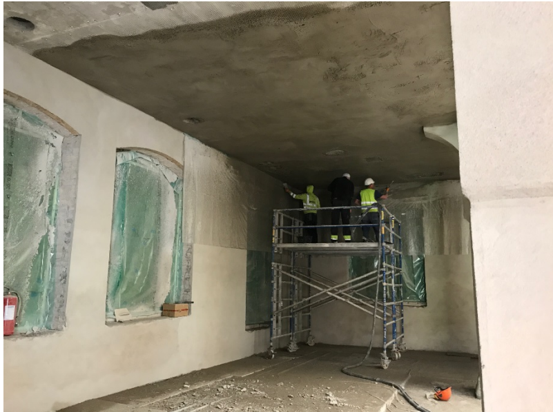
Figur 5, Pågående putsningsarbete i stora salen.
