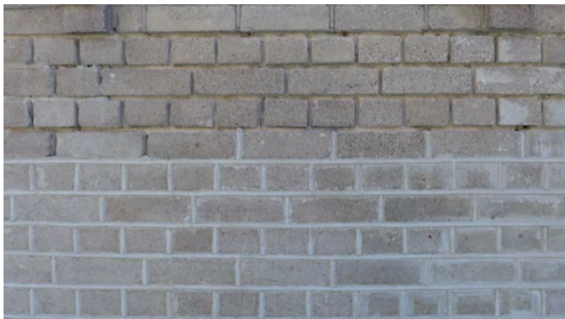
Figur 7, Renovering av fogar i fasad till ursprungsskick.
