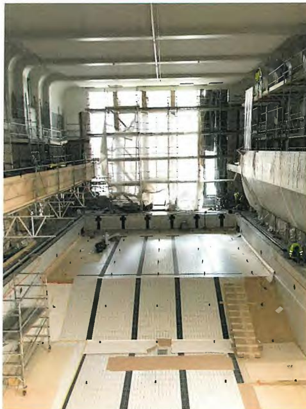
Färdigställande av badet pågår. Stora bassängen är täthetsprovad och kaklad.
