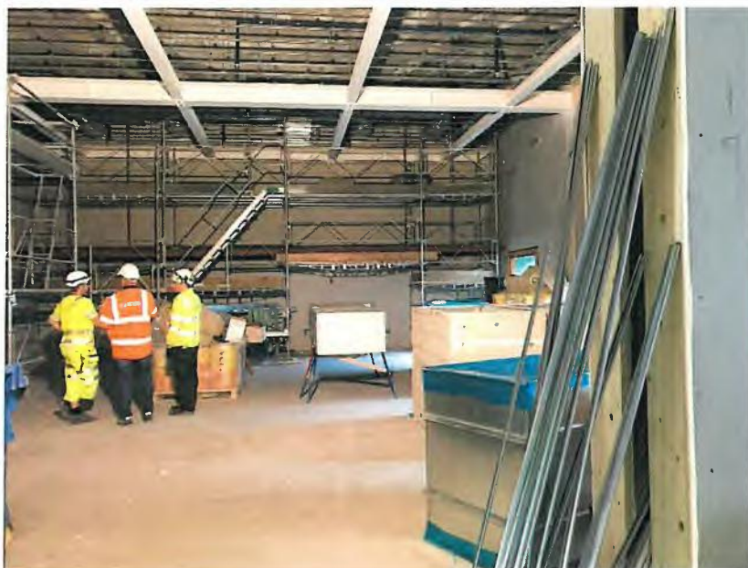
En av de blivande teaterlokalerna med stomförstärkning och grundkonstruktion för rår utfört.
