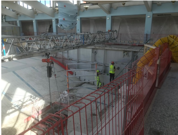
Rivning av 25-metersbassäng. 1 m 3 betong lyfts i taget med lyftanordning och hissas sedan ned genom ett hål till badvattenreningsutrymmet.
