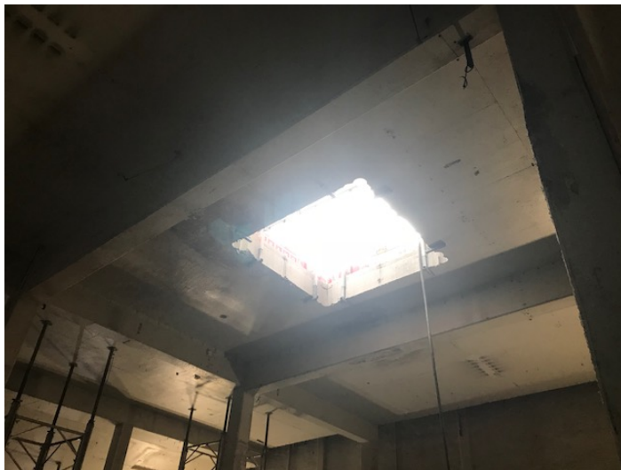
Genom hålet hissas riven betong från 25-metersbassäng ner till vattenreningsutrymme, där det krossas och transporteras ut genom garageporten för vidare borttransport.
