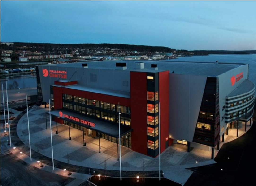
1.8.1 Exteriör, evenemangshall Örnköldsvik, totalt är den 23 meter hög, cirka 7 000 kvadratmeter stor. Arenan har 7 600 platser vid sportevenemang och har kapacitet för 9 600 platser vid konserter och andra evenemang.
