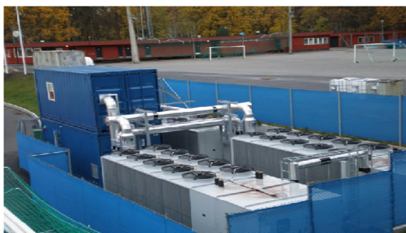
4.3.1 Utomhusuppställda enhetsaggregat
