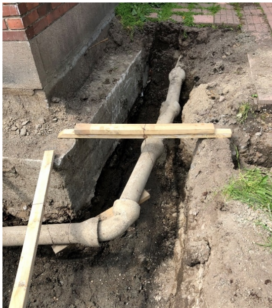
Figur 5: Markisolering saknas, gammal ledning i dåligt skick
