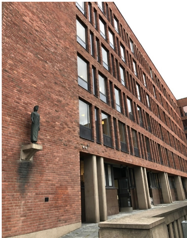
Figur 4: Lagade partier smälter väl in i den ursprungliga fasaden
