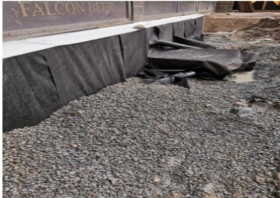
Figur 7: Uppfyllnad med dräneringsmaterial
