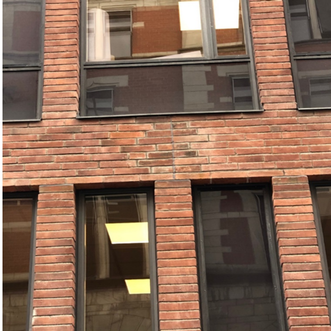
Figur 3: Lagade partier smälter väl in i den ursprungliga fasaden
