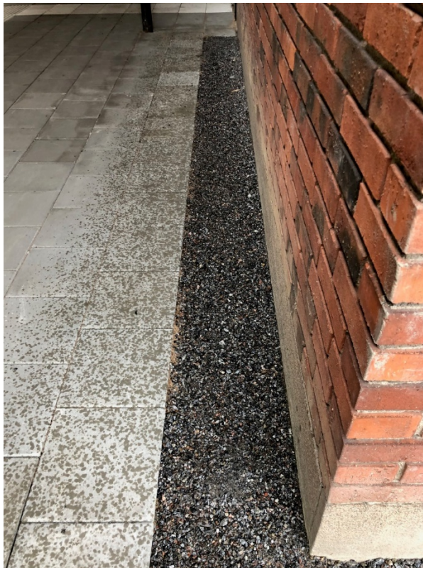
Figur 8: Slutresultat efter utförda mark- och dräneringsarbeten
