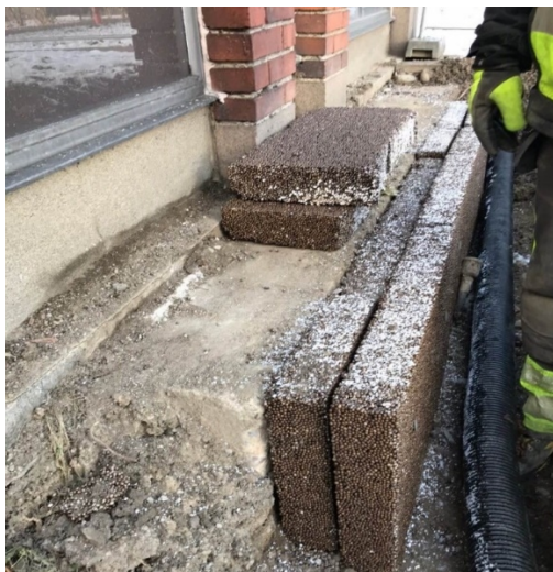
Figur 6: Arbete med dränering och markisolering
