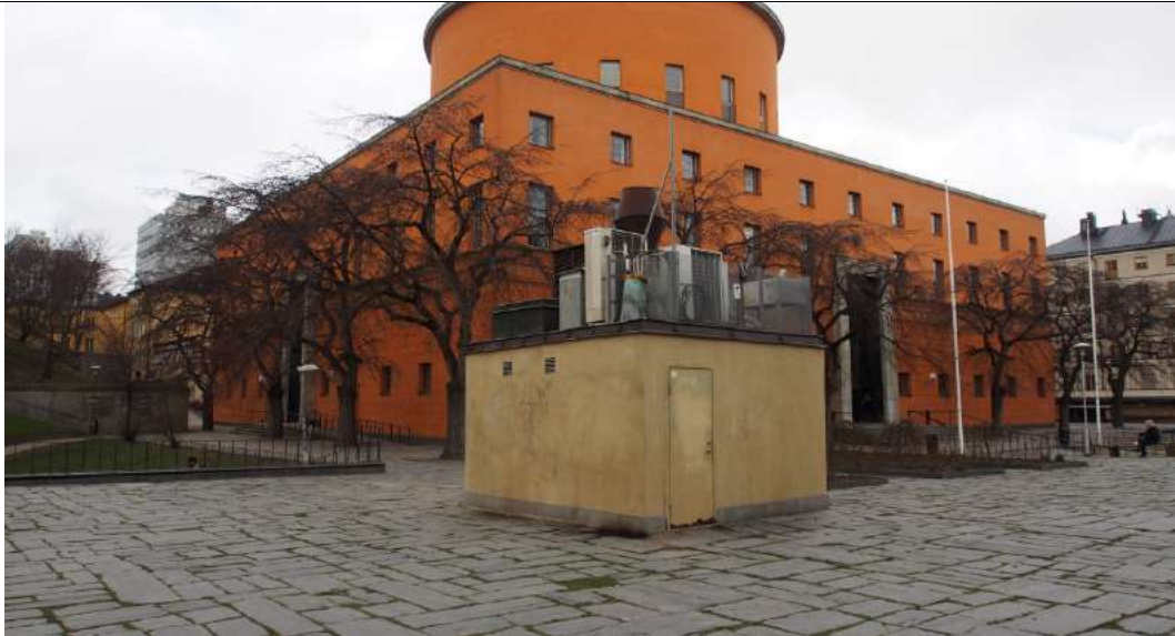
Bild på befintligt skick södra terrassen
