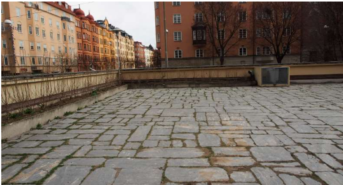
Bild befintligt skick norra terrassen
