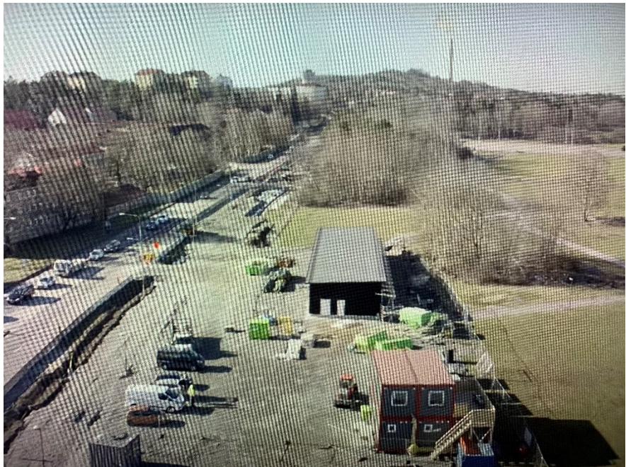
Bild över servicebyggnaden.
