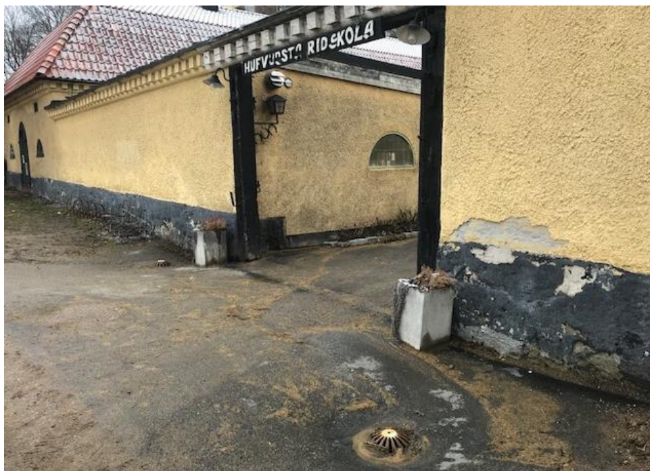
Bild 5. Entré till Huvudsta ridskola, Brunnarna på bilden leds till svackdike för rening innan avledning till Ulvsundasjön. Foto: Stina Thörnelöf
