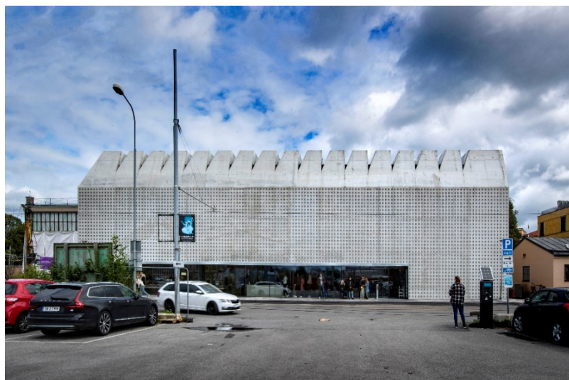
Fasad mot Falkenbergsgatan, huvudentrén Liljevalchs+. Foto: Lennart Johansson
