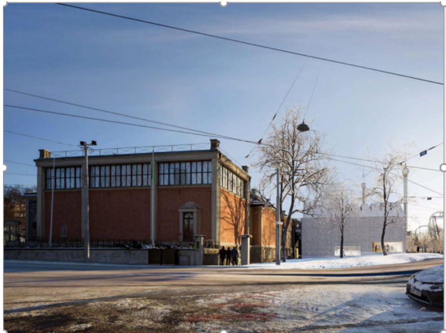
Befintliga konsthallen Bergstenshuset. Till höger ses tillbyggnaden (Liljevalchs+). Illustration: Wingårdhs arkitekter
