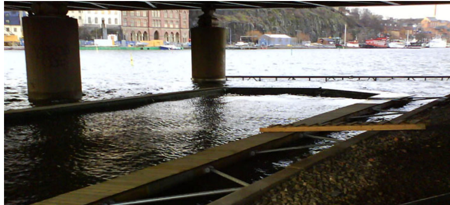
Skärmbassäng som tidigare fanns under Centralbron/Söderström. Foto från utredningsrapport om anläggningens funktion 15 .
