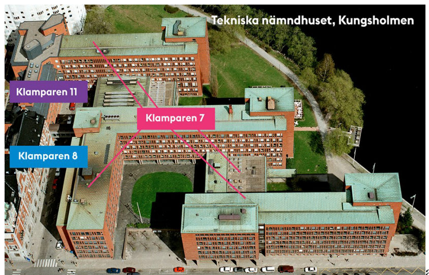
Tekniska nämndhusets olika fastigheter.
