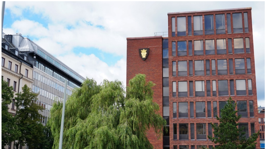
Östra fasaden på Tekniska nämndhuset.
