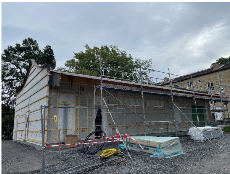
Omklädnings- och servicebyggnad under uppförande.
