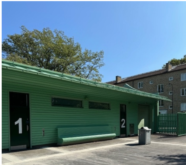
Bild efter uppförande, ingång till omklädningsrum.
