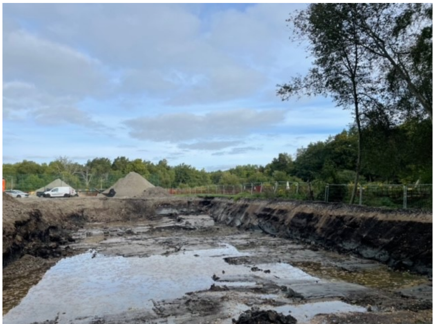
Sanering av förorenade massor. Svarta massor är aska.
