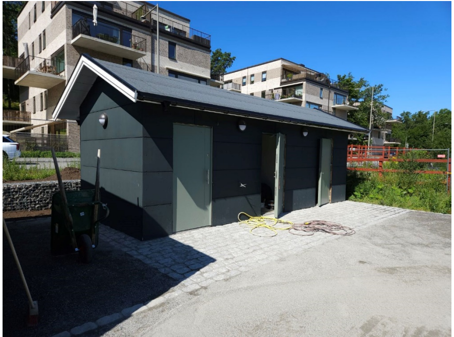
Toalettbyggnad under uppförande.
