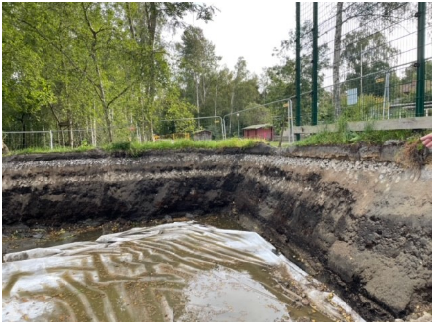
Saneringsarbete av förorenade massor, de svarta massorna är askan.
