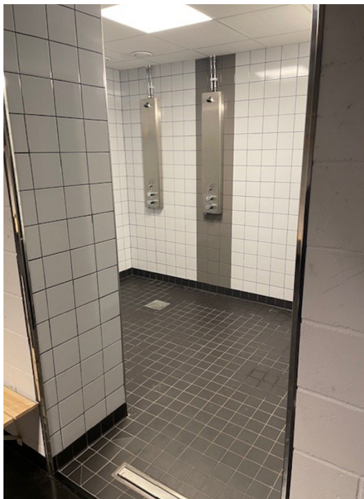
Duscharna i omklädningsrummen.
