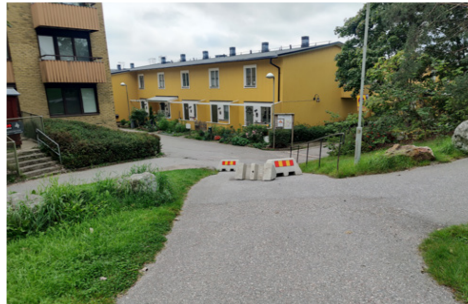
Figur 34: Betongsuggor på gångbana, öster om Akalla By
