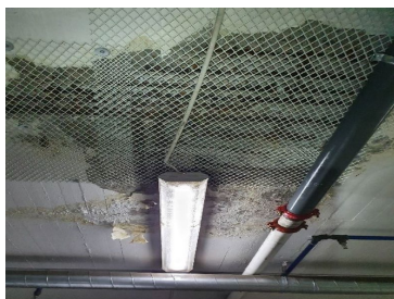
Bild 1 och 2: Betong som spricker p.g.a. armering som rostar/expanderar och skjuter sönder betongen samt nät som hindrar mot person- och egendomsskador. Bild 2 visar även hur pelare har tagit skada från läckage samt hur rörändar sticker ut från våningsplan ovanför mm.
