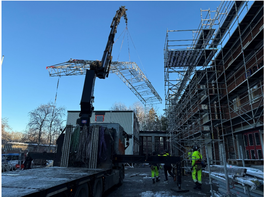
Montage av väderskydd för taket.
