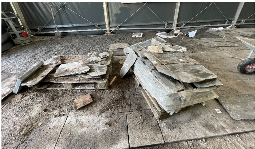
Pågående arbete med återläggning av skifferplattor. Foto: Maria Sköld Wulf
