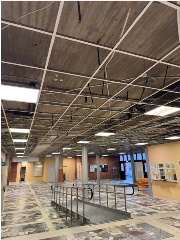
Undertakspaltor nedtagna för säkerställande av projektering rördragning.
