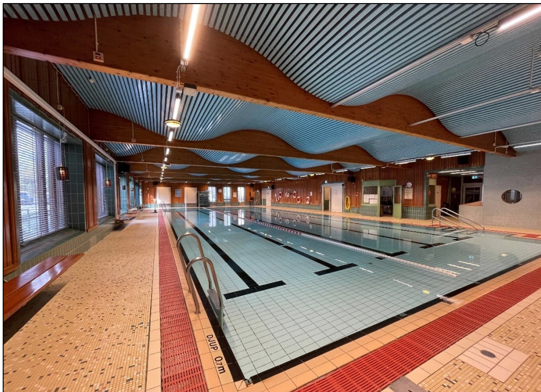
Figur 1.6. Vy över simbassängen från den grunda delen. Det finns bärande limträbalkar i taket.
