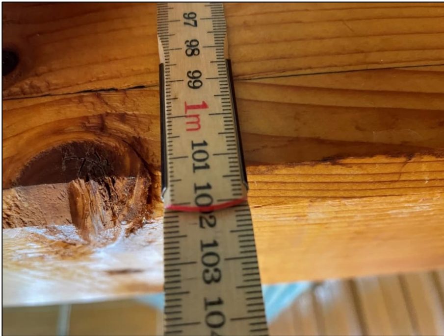
Figur 8.3. Inmätning höjd av befintlig L-träbalk, mått 1015mm, (foto AFRY 2925-05-02).
