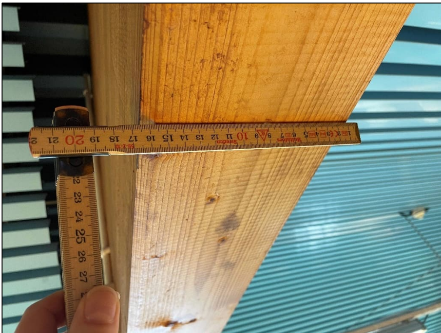
Figur 8.4. Inmätning höjd av befintlig L-träbalk, mått 165mm, (foto AFRY 2925-05-02).
