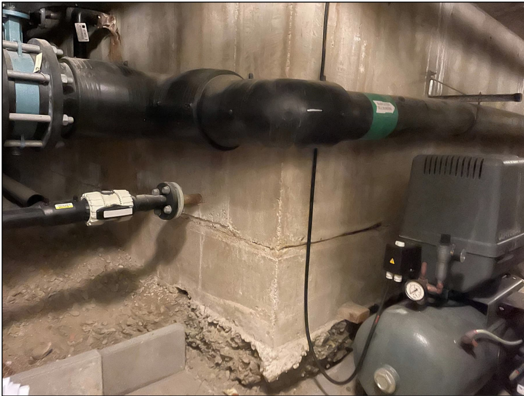
Figur 2.3. Bild 2, (foto AFRY 2025-03-03). Kantbalken är ca 35–40 cm hög.
