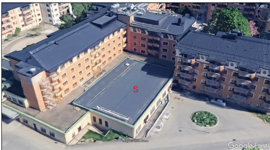
Figur 1.2. 3D-vy över Sandborgsbadet (S), (från Google Earth 2025-03-12). Taket är platt med invändiga stuprör.
