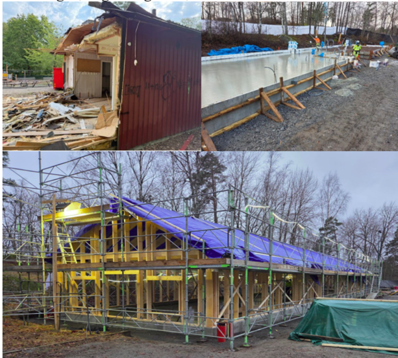
Rivning av den uttjänta byggnaden samt uppförandet av den nya parkleksbyggnaden under produktion.
