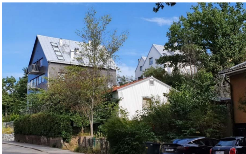
Villa på fastigheten Sothönan 10 och bakomliggande uppförda flerbostadshus på fastigheterna Sothönan 11 och 14.
