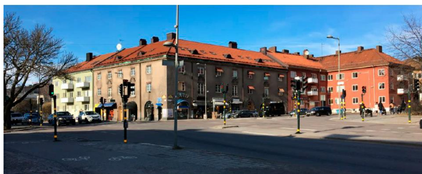
Vid gamla Älvsjö torg är karaktären mer stadslik med lokaler i bottenvåning och kvarter som är slutna mot gata.
